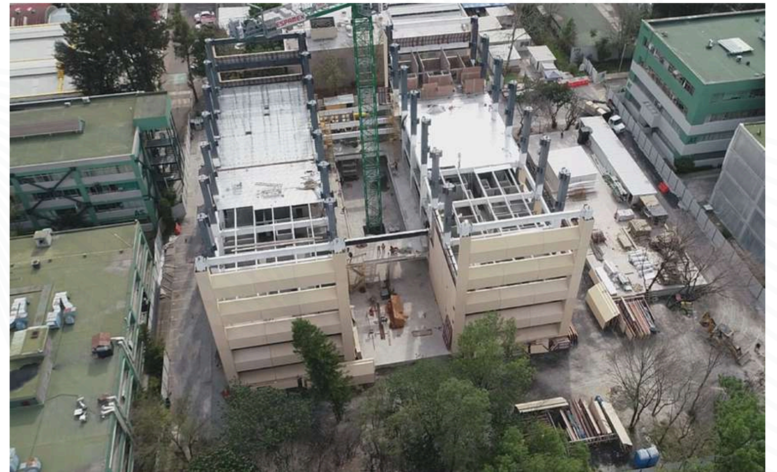
Trabajos de obra para el nuevo edificio S durante enero del 2022.
